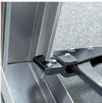
Posizionamento della punzonatrice su due profili in lamiera da unire
